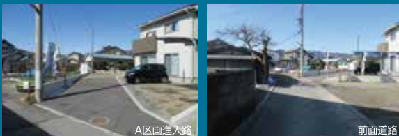
A区画進入路
